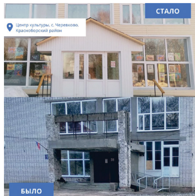
С момента постройки здания Черевковского центра культуры до его капитального ремонта прошло 40 лет
