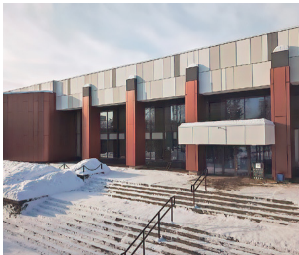
Фасад после ремонта
